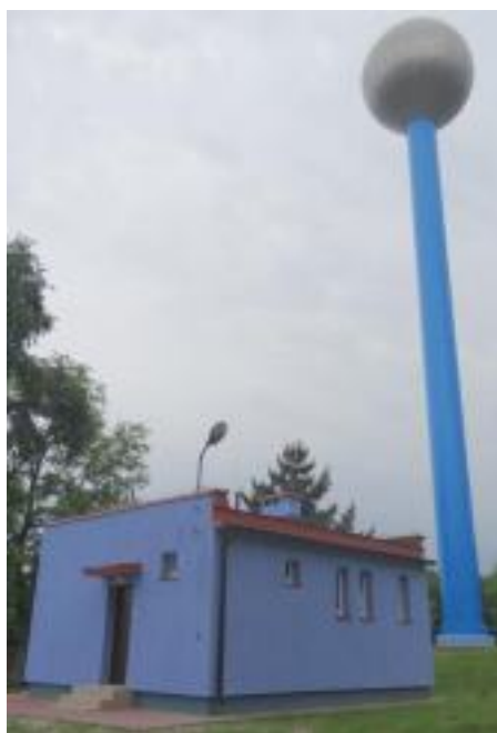
Zmodernizowane ujęcie wody w Pierzchniancie.
